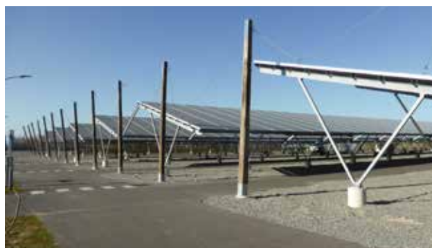
De nieuw aangelegde zonnecarport aan de N302
