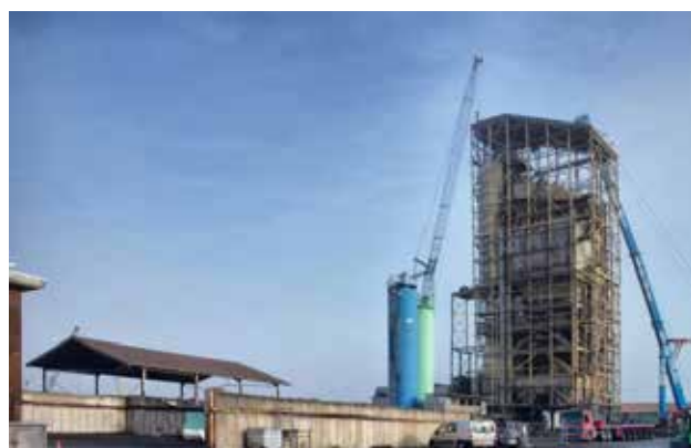
De sloop van de 'Bruiltoren'
