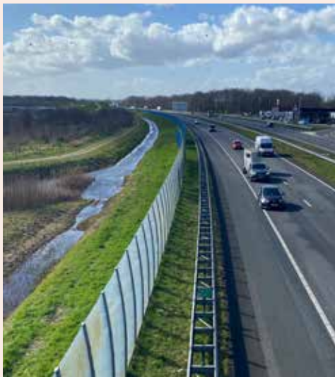
De geluidsschermen langs de A28 ter hoogte van Drielanden worden deels opgehoogd. Bron: Gemeente Harderwijk
