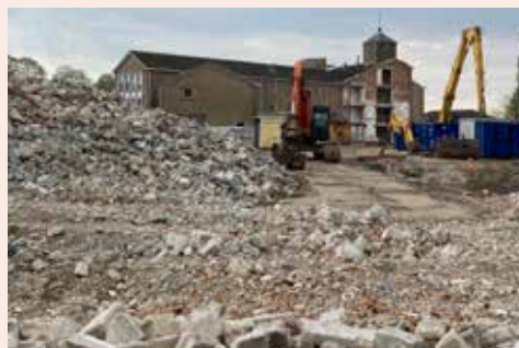
De sloop van Woonzorgcentrum Randmeer
