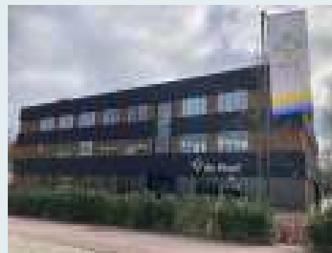
Het gebouw De Roef
